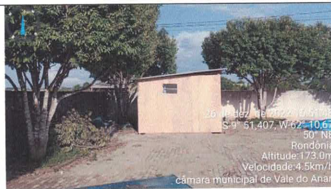
20. Execução do almoxarifado concluída
