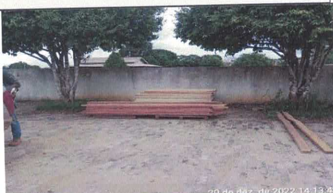
2. Descarregamento do material para execução dos tapumes
