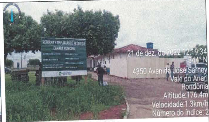
8. Placa de obra locada
