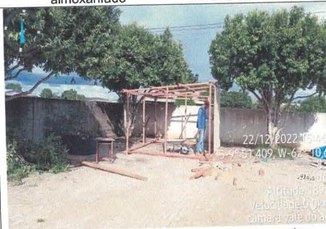
13. Execução das paredes em compensado
