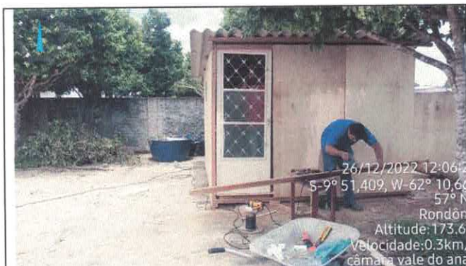
19. Instalação da porta
