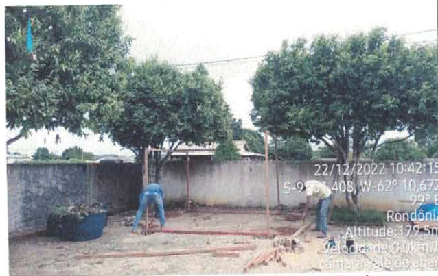
11. Remoção dos blocos para execução do alboxarifado
