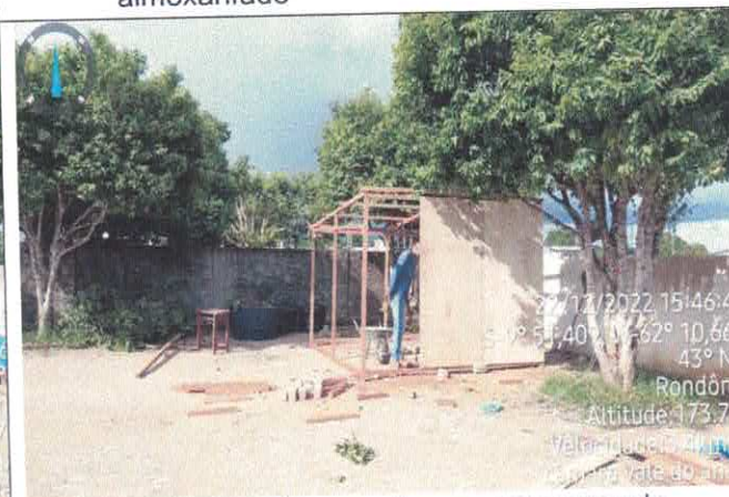
14. Execução das paredes em compensado
