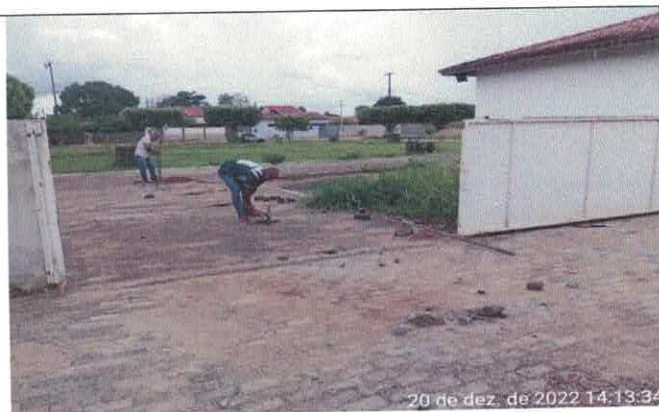
4. Locação dos caibros para instalação do tapume
