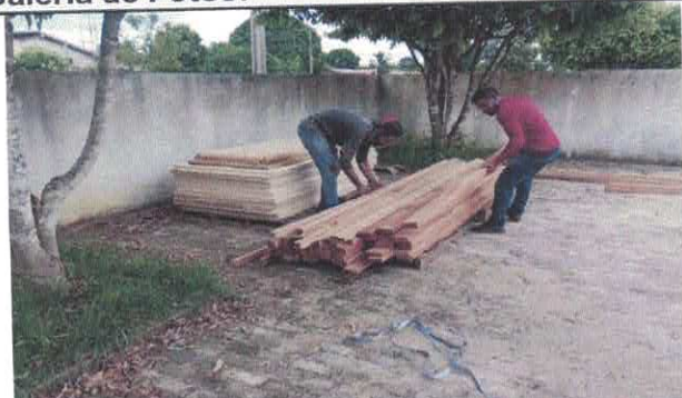
1. Descarregamento do material para execução dos tapumes
