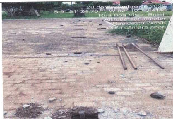
3. Locação dos caibros para instalação do tapume
