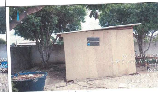
18. Instalação da janela
