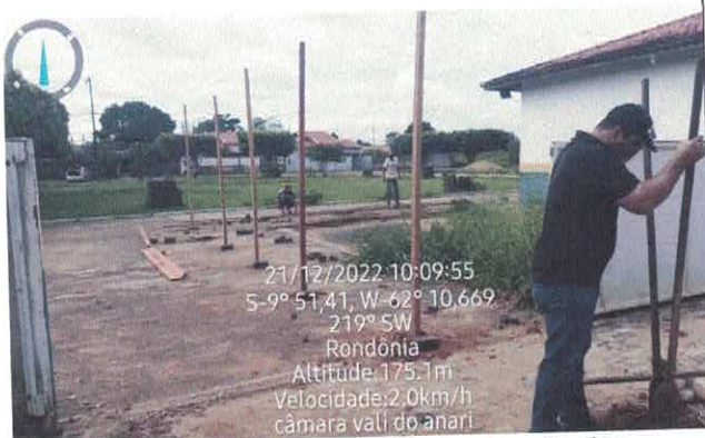
5. Locação dos caibros para instalação dos tapumes
