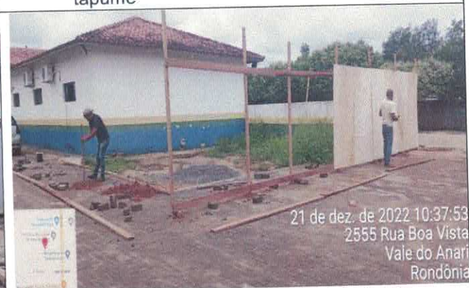
6. Locação dos caibros para instalação do tapume
