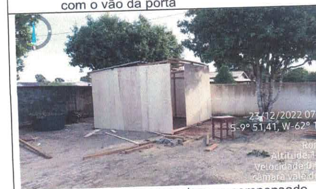
17. Execução das paredes em compensado
