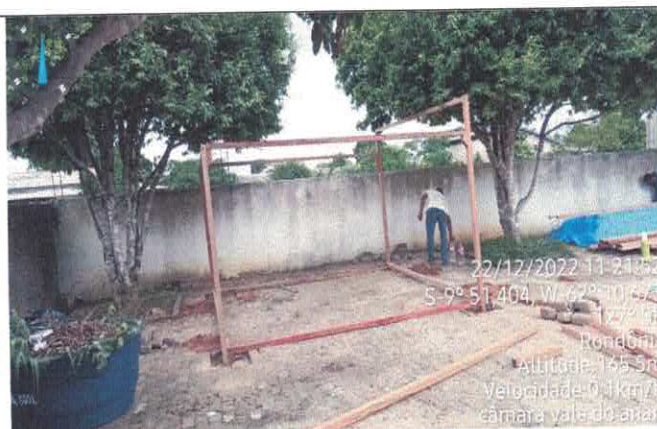
12. Execução da estrutura de madeira para o alboxarifado
