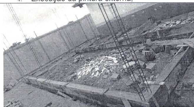
6. Concretagem das vigas baldrame;
