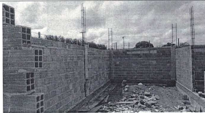
8. Execução da alvenaria de vedação;
