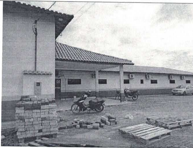
17. Pintura finalizada na parte externa;
