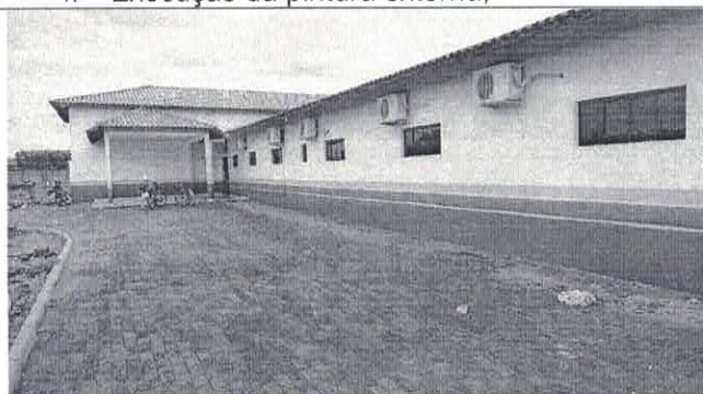
3. Execução da pintura externa;
