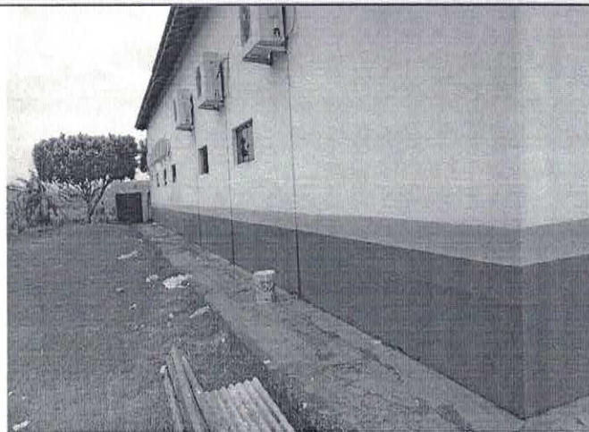
2. Execução da pintura externa;
