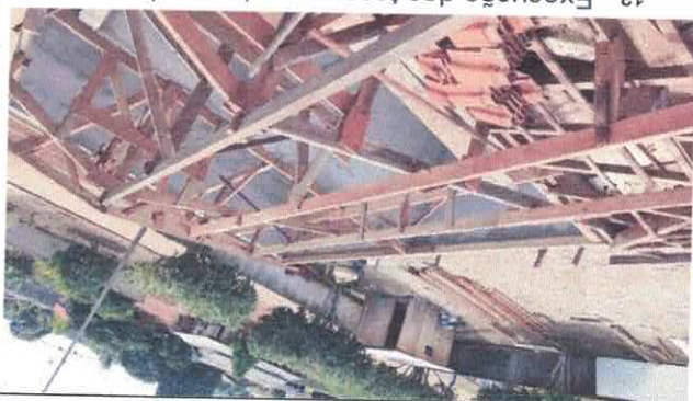
13. Execução das tesouras e trama de madeira;
