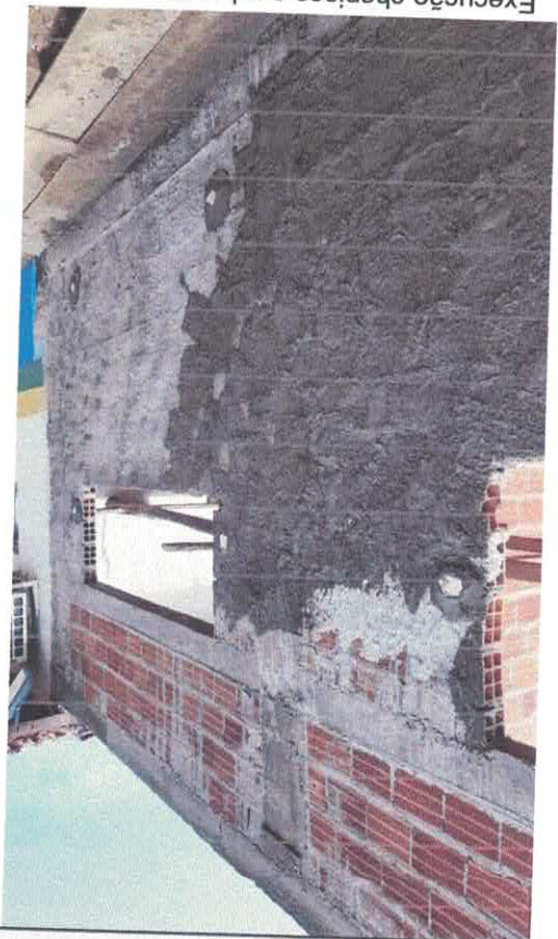
1. Execução chapisco e reboco;
