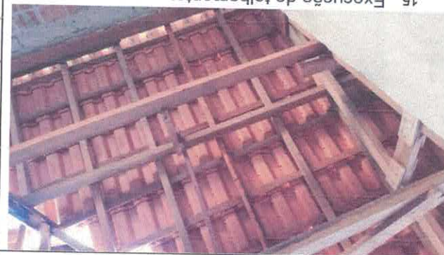
13. Execução das tesouras e trama de madeira;
