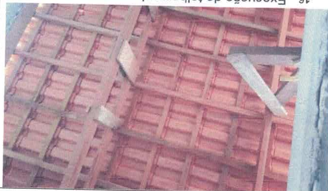
14. Execução das tesouras e trama de madeira;
