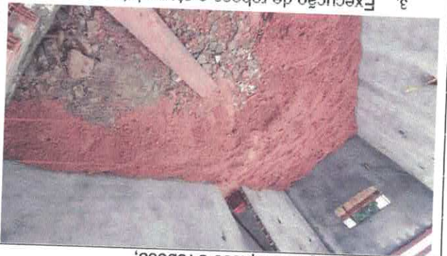
1. Execução chapisco e reboco;
