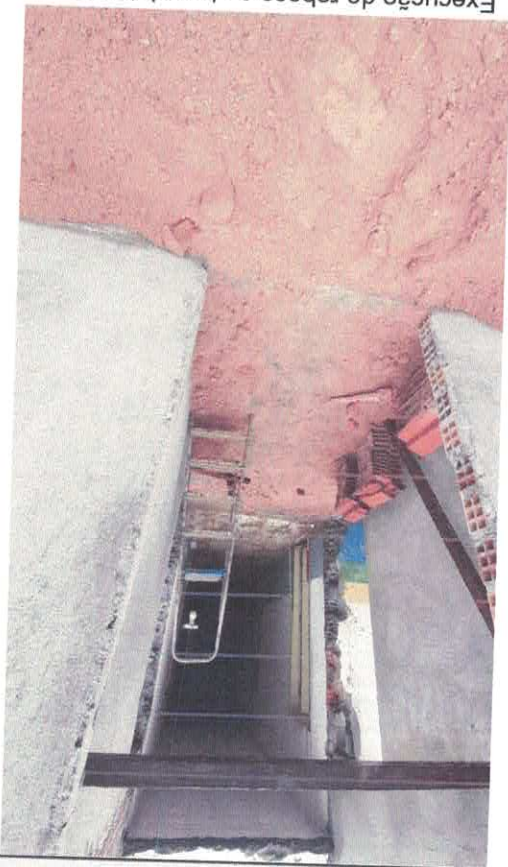
2. Execução de reboco e aterro interno;
