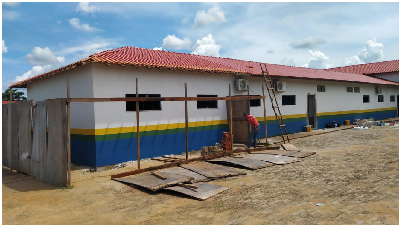
19. Área externa da edificação.
