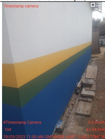
3. Lateral externa da edificação;
