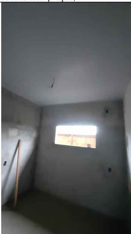
7. Interior da edificação;
