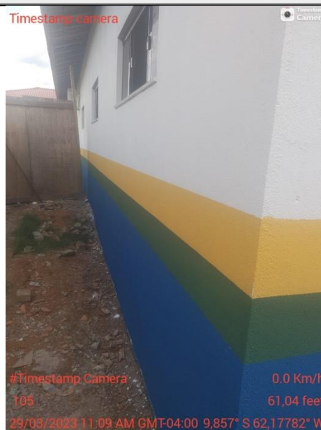
2. Lateral externa da edificação;
