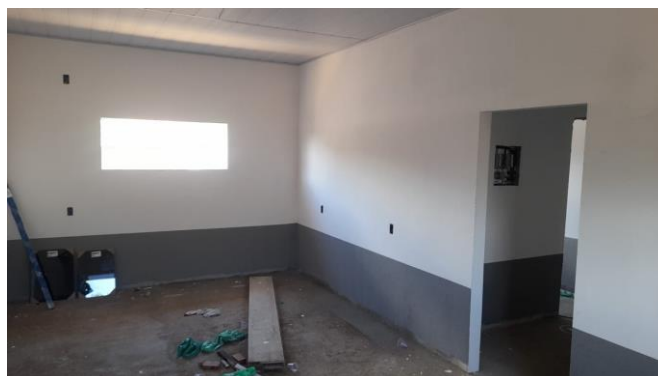
10. Interior da edificação;
