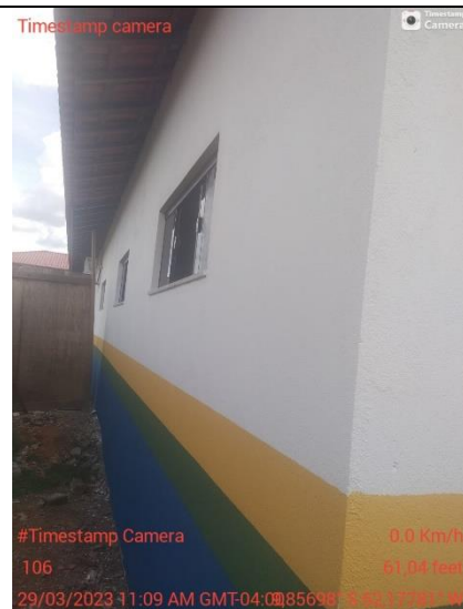
4. Lateral externa da edificação;
