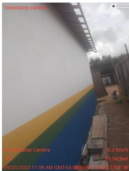
1. Lateral externa da edificação;
