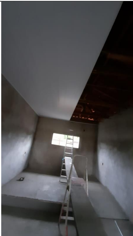
9. Interior da edificação;
