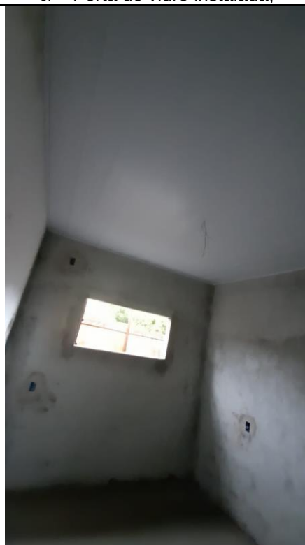
8. Interior da edificação;
