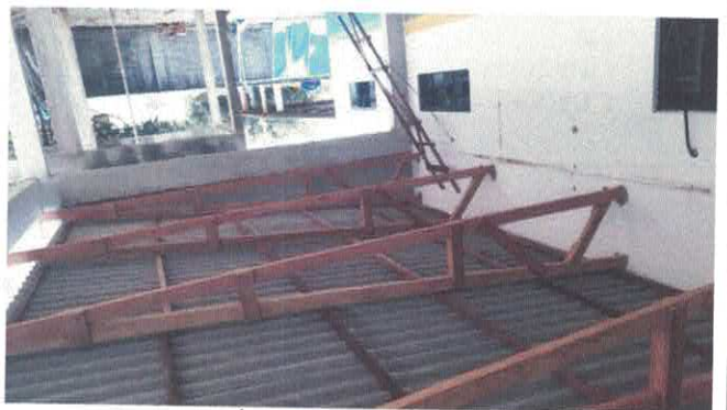
1. Madeiramento da cobertura;
