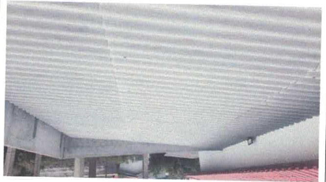
3. Cobertura da garagem;
